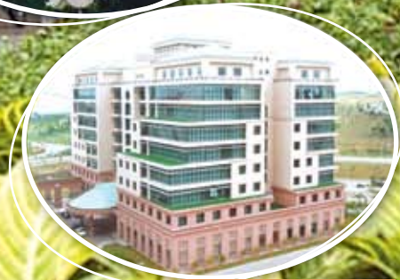
Kompleks C, Bangunan SPA Putrajaya
