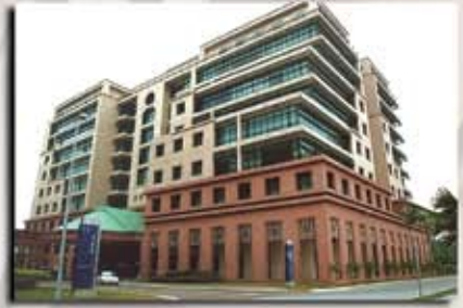
Kompleks C, Bangunan SPA Putrajaya
