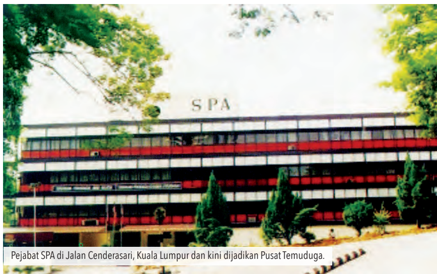
Bangunan lama SPA di Jalan Cenderawasih, Kuala Lumpur.
